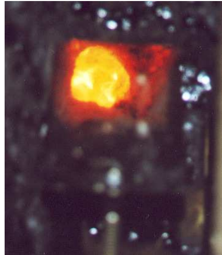
Bild 7: Kaminbrand aus dem Blickwinkel eines Kaminspiegels
