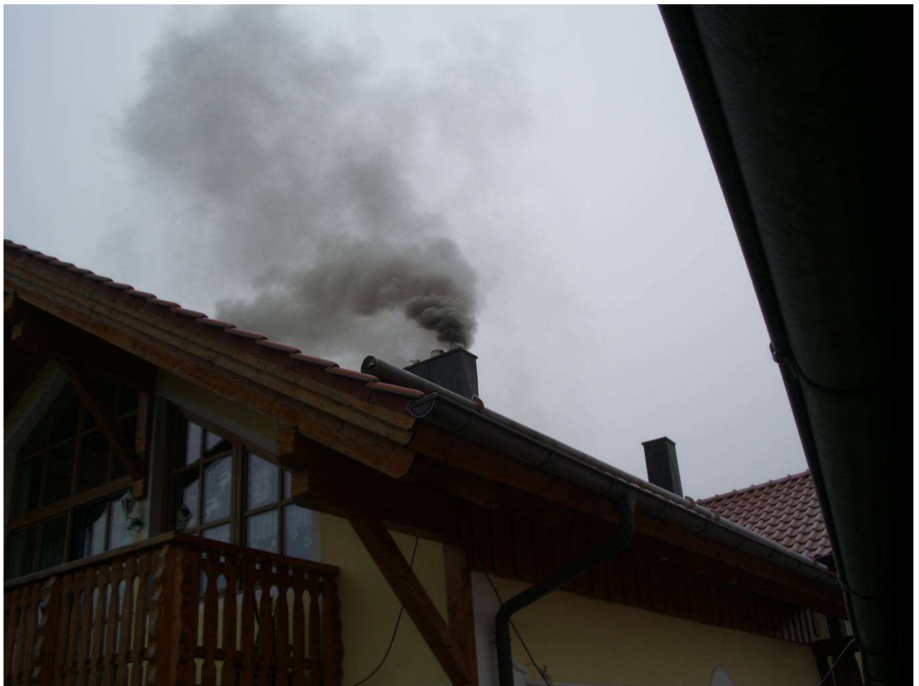
Bild 1: Kaminbrand in der Entstehungsphase
