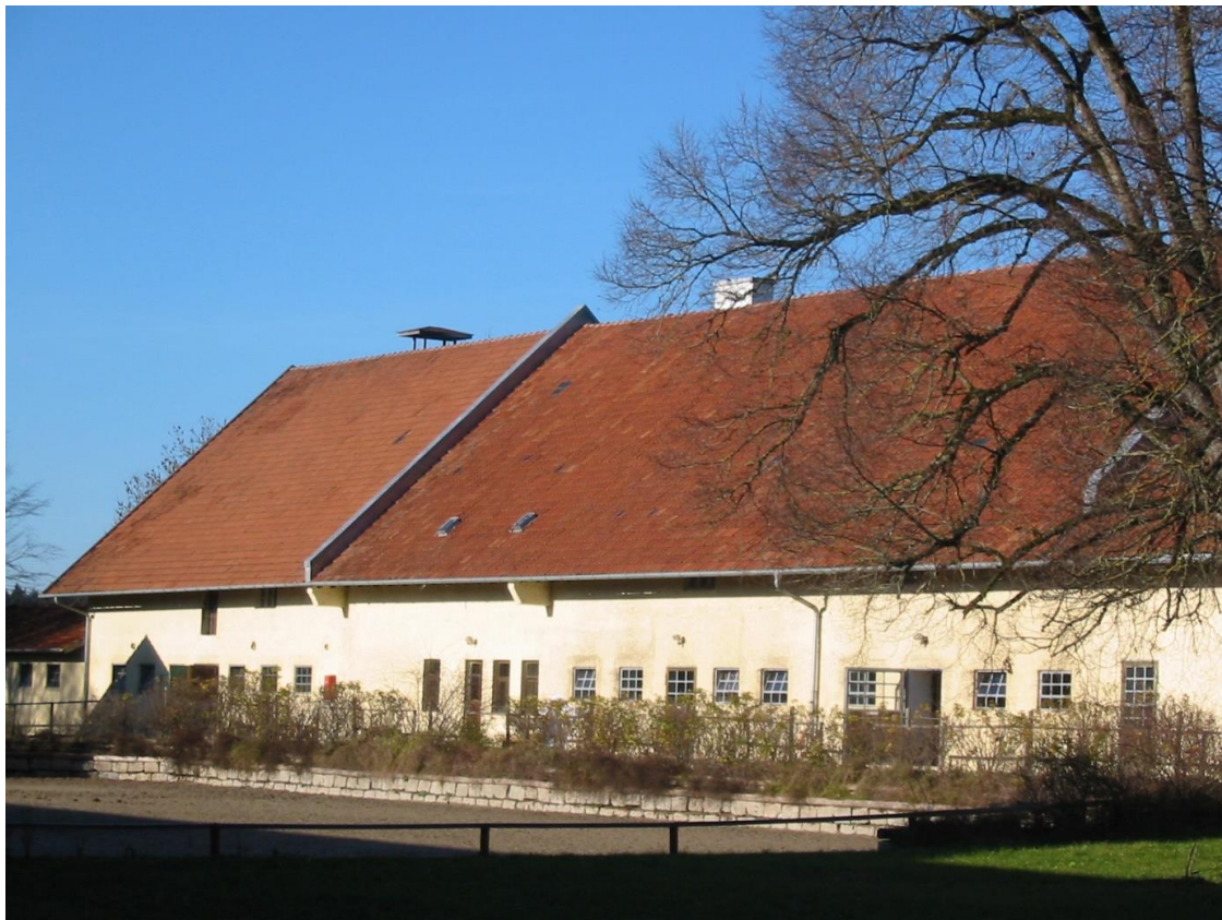
Bild: Gebäude im Außenbereich - über Dach geführte Brandwand
