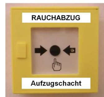
In beiden Fällen sind die Öffnungen zur Rauchableitung in Treppenträumen oder Aufzugschächten wichtige baurechtliche Bestandteile. Außer bei Sonderbauten (vgl. SPrüfV) stellen jedoch Rauchableitungsöffnungen keine sicherheitstechnischen Anlagen dar und bedürfen keiner Überprüfung nach der SPrüfV.
