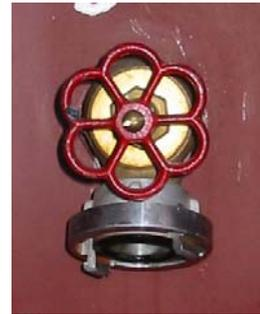
In der DIN 14 462 wird aber der **Teil 5** (90 Grad Krümmer mit Feuerweherschloss bedienbar) der DIN 14 461 als Entnahmestelle genannt. (Bild rechts)
