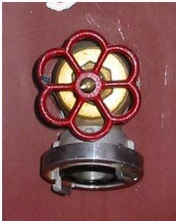
Als **Entnahmestelle** hat sich seit den siebziger Jahren der **Teil 3** (Handrad mit C-Anschluss) der DIN 14461 in Bayern bewährt. (Bild links)
