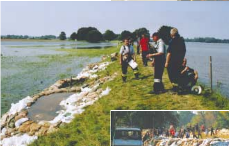
Unterspülungen mussten fachgerecht mit Sandsäcken abgedichtet werden.
