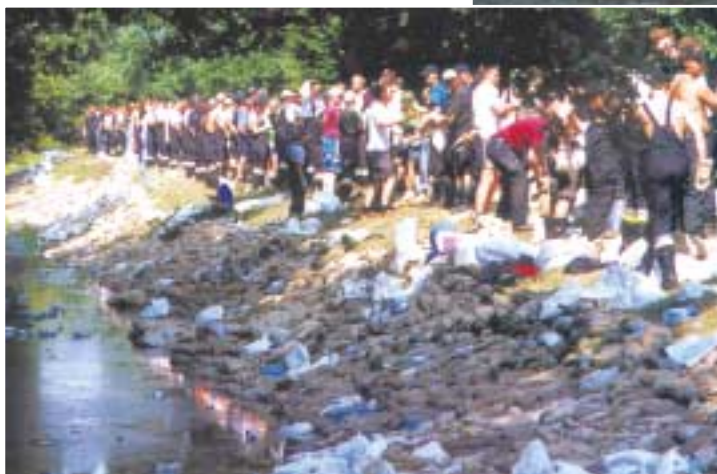
Alles war auf den Beinen. Helfer und Bevölkerung beim Dammbau. Die FW-Kameraden auf Pfaffenhofen, München und Würzburg verbauten allein in Großkühnau zur Rettung der Kläranlage 100000 Sandsäcke.
