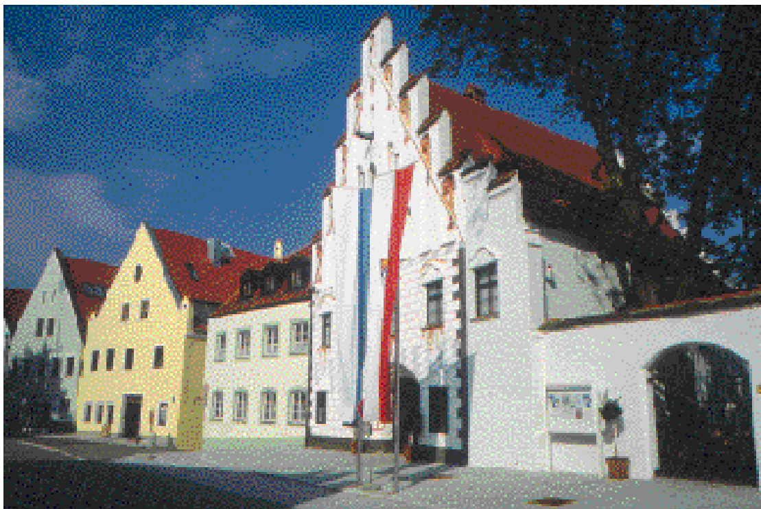
Die Herzogsburg - eines der markantesten Bauwerke der niederbayerischen Kleinstadt Dingolfing.
