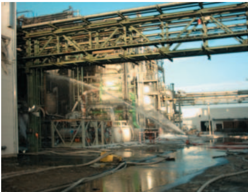
Einsatz beim Brand im Industriepark Münchsmünster
