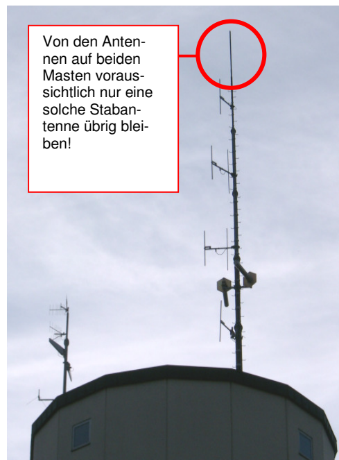
Bild: Funktechnik Rupp, Osterhofen Wasserturm Obertunding: Analoge Funkstellen der Feuerwehr, des Rettungsdienstes, der Polizei und des Katastrophenschutzes
