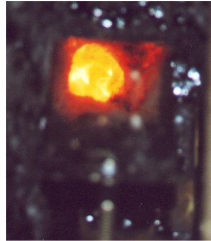
Bild 7: Kaminbrand aus dem Blickwinkel eines Kaminspiegels
