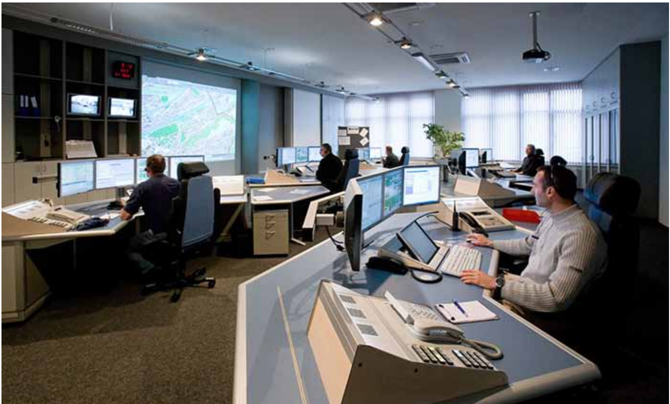
Bildunterschrift: „Notrufannahmestelle Integrierte Leitstelle Landshut“
